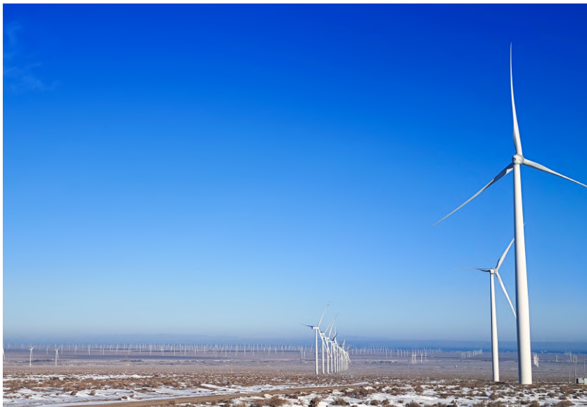
甘肃玉门黑崖子风电场 50台变桨改造单机容量2MW SPS103变桨系统
