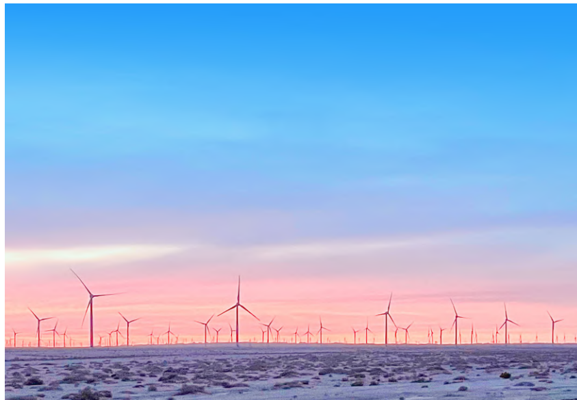
甘肃玉门麻黄滩风电场 94台变桨改造单机容量2MW SPS103变桨系统
