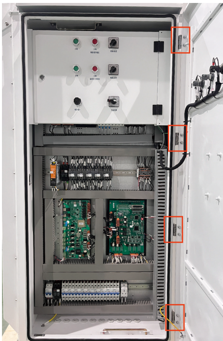
图 3-3 铰链示意图
