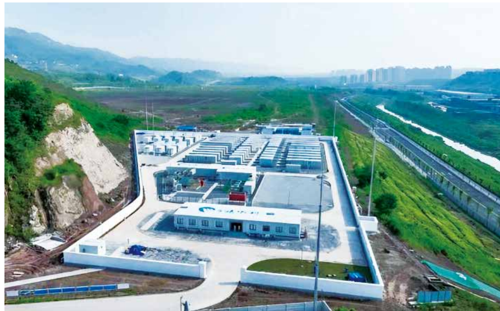
2023 年西南地区规模最大的新型储能电站 - 三峡重庆 永川松溉 200MW / 400MWh 储能电站
