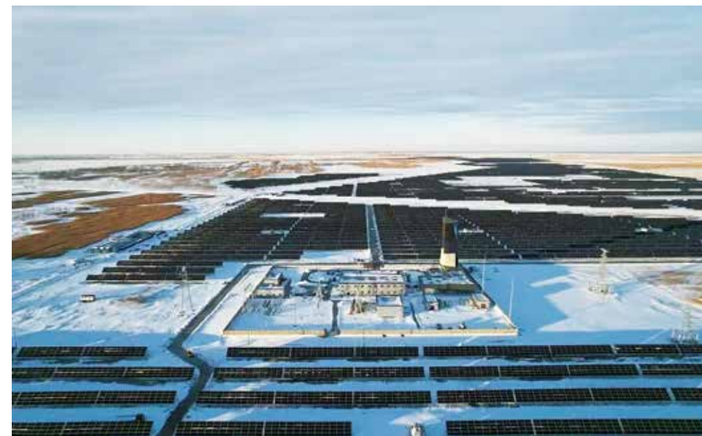
2021 年国家首个光储实证实验平台大庆基地储能系统
