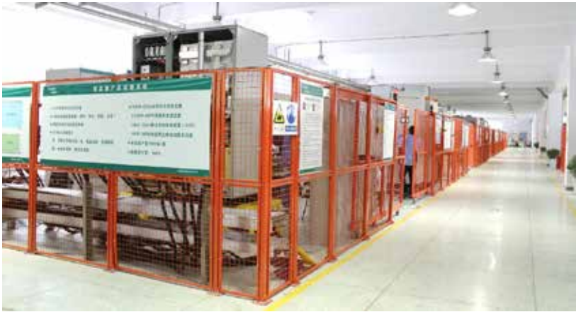
全压满功率运行试验区
