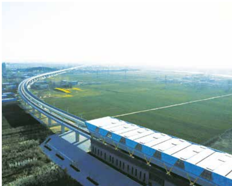
2022 年国内首条全线采用超级电容储能线路郑许市域铁路工程
