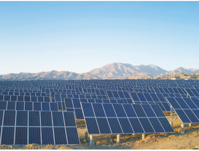
中电投龙羊峡 320MWp 水光互补项目
