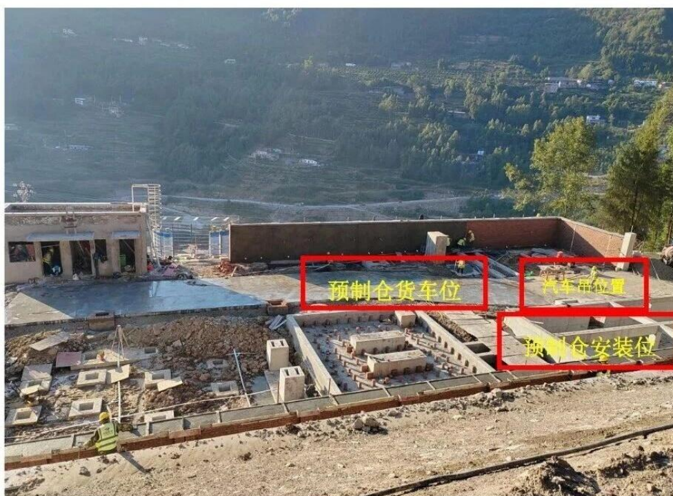
图 4.3-5 10kV 预制舱吊车位置示意图
