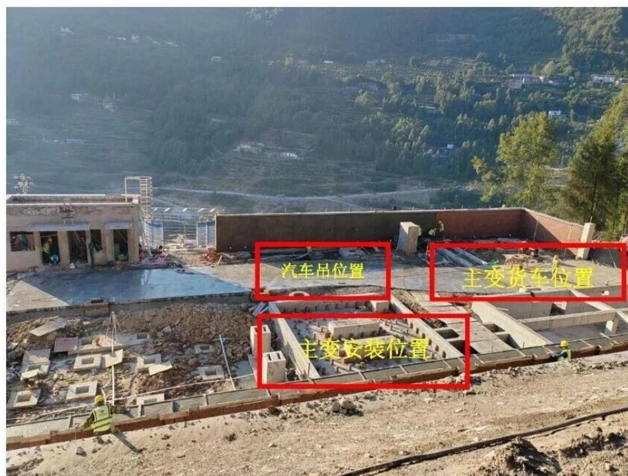
图 4.3-3 主变压器吊装位置示意图
