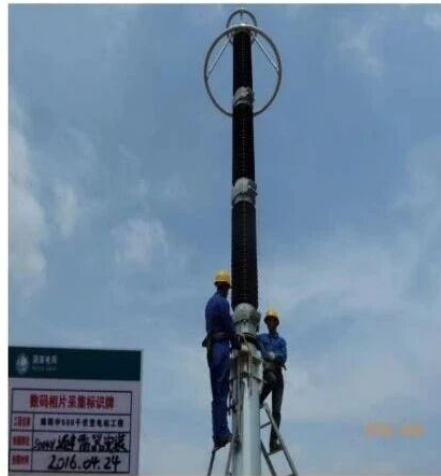
图 4.2.2-1 避雷器安装
