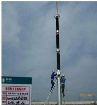
图 4.2.1-1 电压互感器安装
